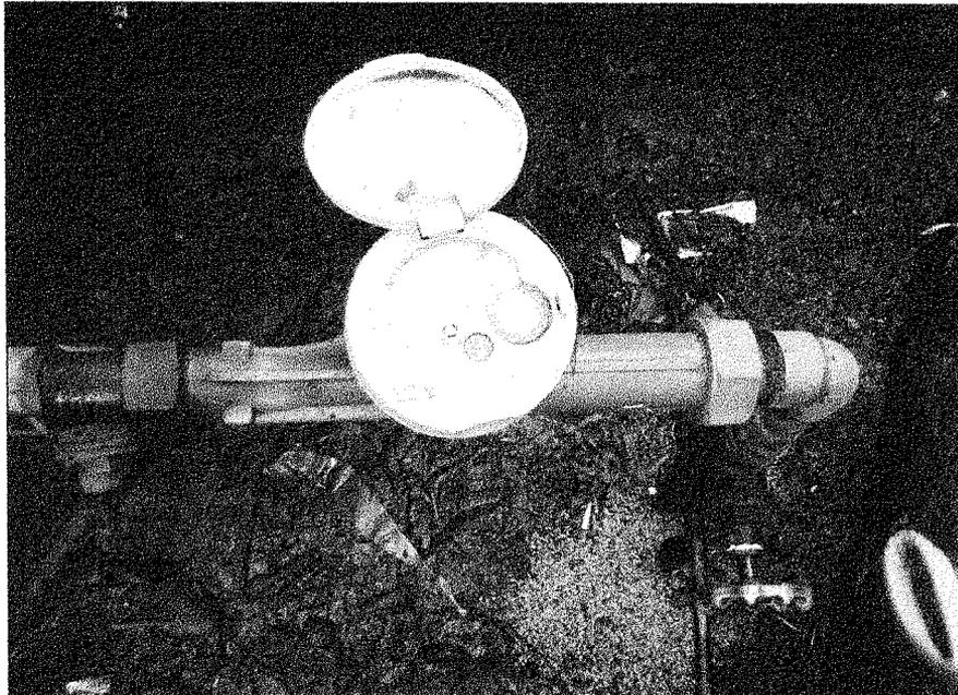
DIAMETRO MEDIDOR: 25mm.
