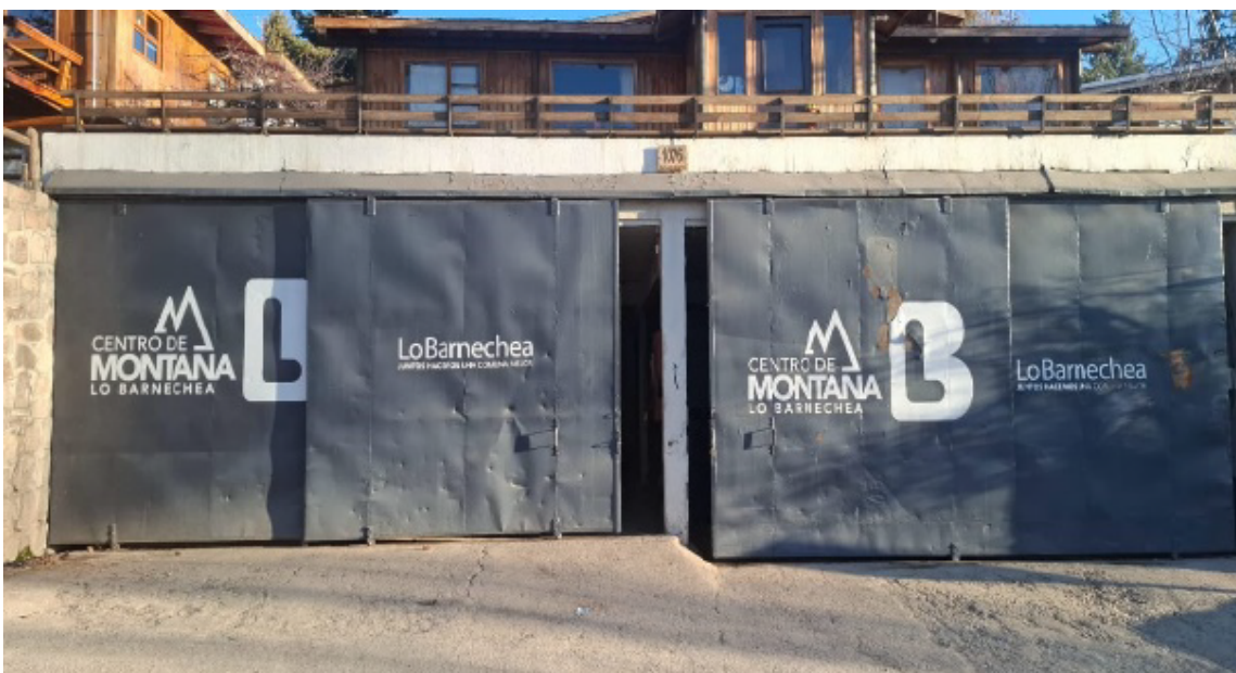
Imagen N°7: Estacionamiento vehicular, 02 hojas; ambas de 4.8m de ancho y 3.0m aproximadamente.
