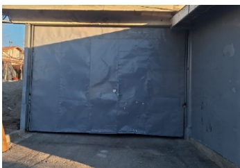
Imagen N°4: Galpón acopio de materiales, tercera hoja de 3.2m de alto y 3.5m de ancho
