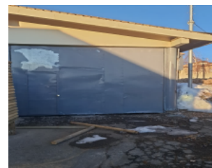
Imagen N°6: Galpón acopio de materiales, con una hoja de 3.4m de alto y 4.8 de ancho
