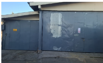
Imagen N°5: Galpón acopio de materiales, la segunda hoja de 3.2m de alto y 6.2m de ancho
