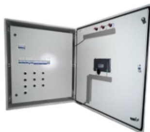
Imagen referencial: Tablero de fuerza y control
