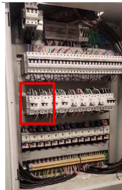
Imagen: Reemplazo de componentes internos del tablero existente.
