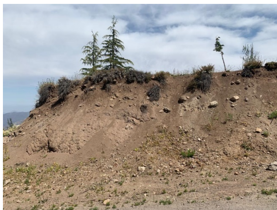
Imagen 7. Aterrazamiento entre un terreno y otro.
